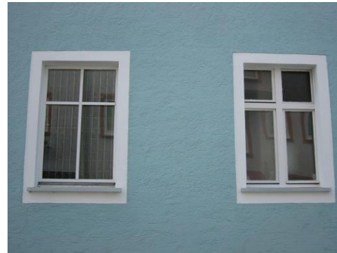
Vergleich zwischen Fenstern mit konstruktiver Sprossenteilung und Fenstern mit aufgesetzten Attrappen
